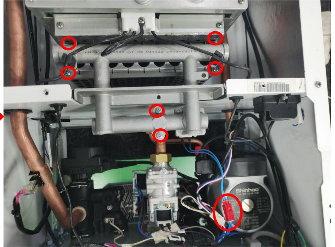
3. Открутить саморезы крепления газового коллектора к горелке и к газовой трубке, затем отключить сегментный клапан.
