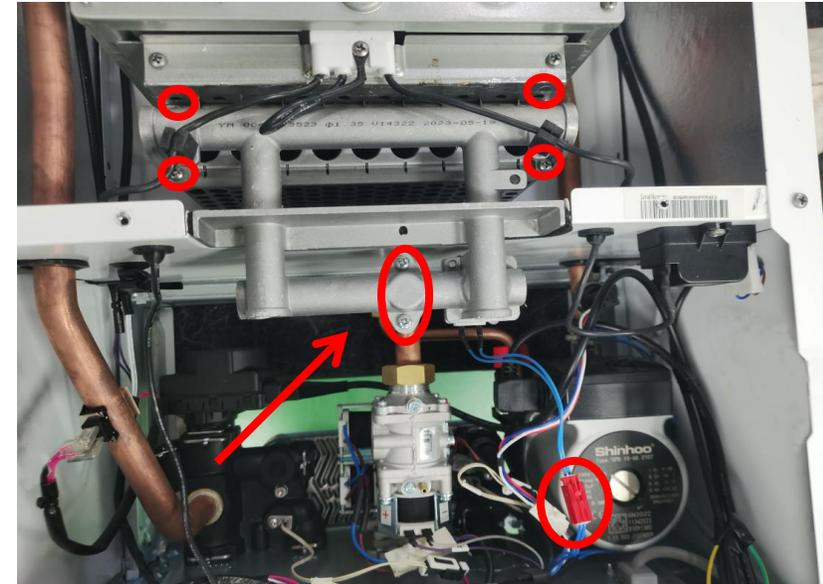
9. Установить в обратном порядке. Убедитесь что кольцо-уплотнитель между газовой трубкой и коллектором на месте! Подключить коннектор сегментного клапана.
