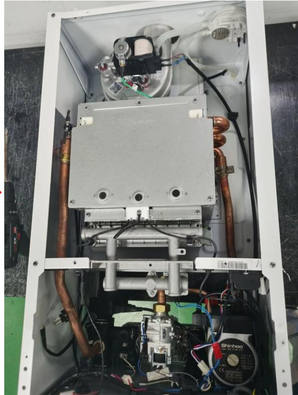
2. Демонтаж крышки газовой воздушной камеры
