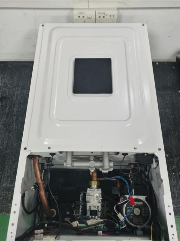
1. Демонтаж лицевой панели корпуса газового котла
